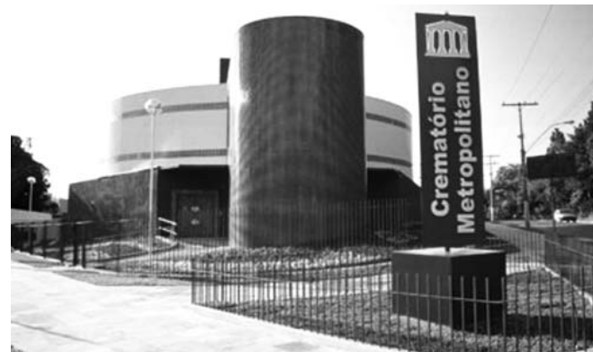
Figura 99 – Prédio administrativo do Crematório Metropolitano. Cemitério São José II
