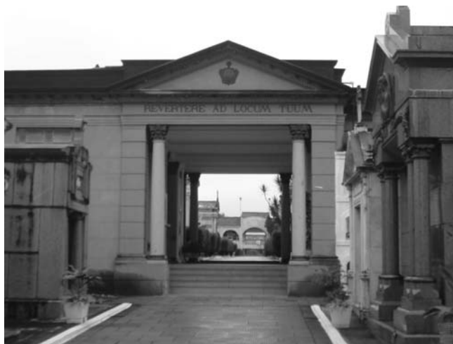
Figura 27 – Pórtico do Cemitério da Santa Casa de Misericórdia
