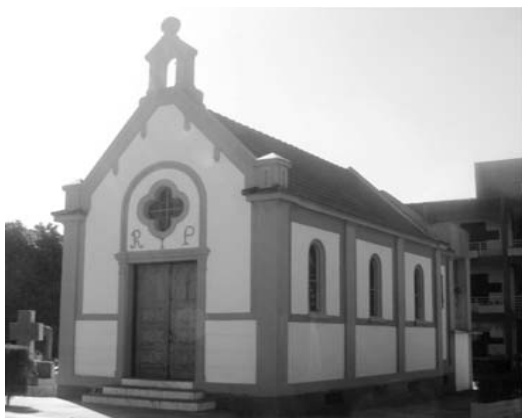
Figura 101 – A capela do Cemitério São José II
