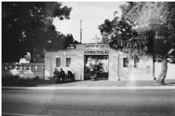
Figura 96 – Segundo portão de entrada do Cemitério São José II (administração)
